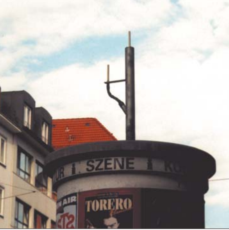
Kleine Antenne zur Versorgung des Nahbereichs (100 bis 500 m).
